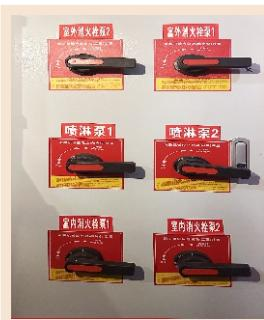
若上述消防泵控制设备均损坏或无法启动可使用下方强启装置进行启动，启动时根据装置上的箭头指示用力旋转把手即可。
