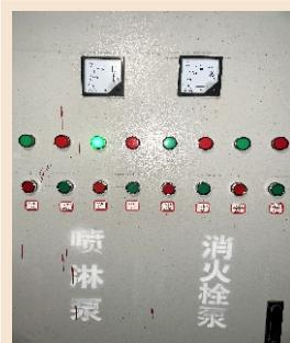
当喷淋或消防栓水压不够使用需求时，通过泵房操作人员到泵房，将开关旋钮旋转到手动，然后按泵1或者泵2进行补水工作。
